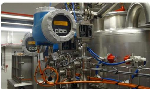
که این ابزار وظیفه اندازه گیری، انتقال، نمایش، ثبت و کنترل پارامترهای مهم فیزیکی را در پروسه های صنعتی به شکلی دقیق بر دوش دارند. ابزار دقیق را میتوان به دو صورت دسته بندی کرد. یکی از نظر نوع عملکرد این ابزار؛ برای مثال ابزاری که عمل کنترل دما یا فشار و رطوبت و یا سطح را بر عهده دارند به کنترل مشهورند و به همین ترتیب ابزار نمایش این مقادیر که به ایندیکیتور یا نمایشگر معروفند و ابزار انتقال اطلاعات مقادیر به صورت سیگنال های استاندارد که ترانسمیتر یا منتقل کننده نامیده میشوند
